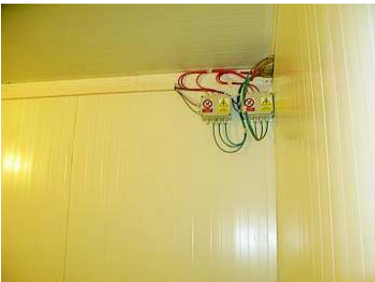
Přívod z panelů do nemocnice
