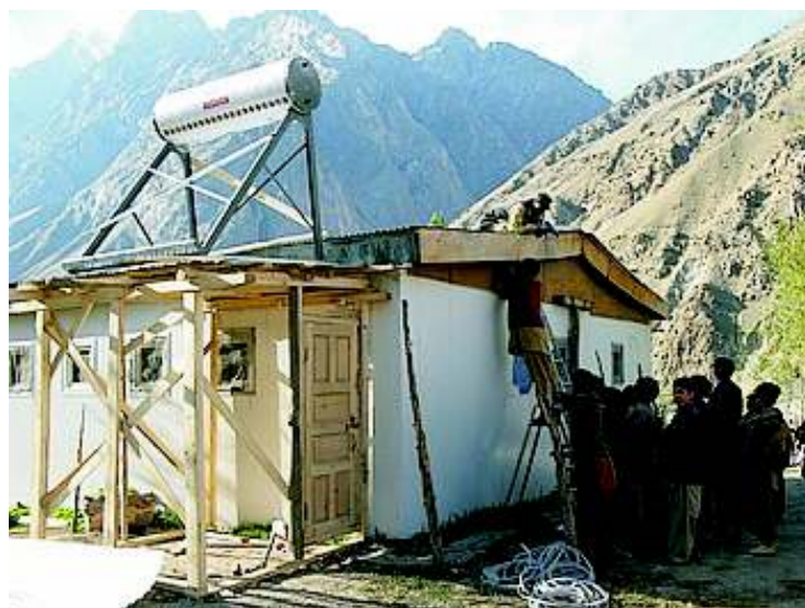
Rozpracované umístění solárního systému nemocnice
