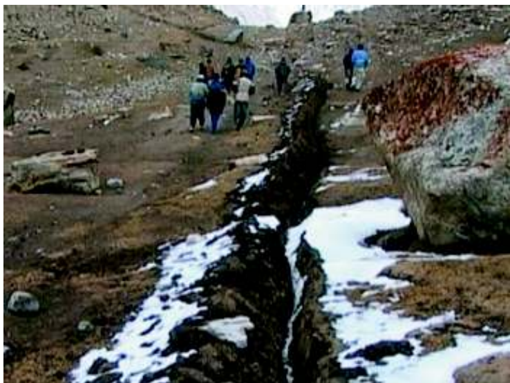
Vykopaná rýha pro vodovodní potrubí od zdroje pitné vody
