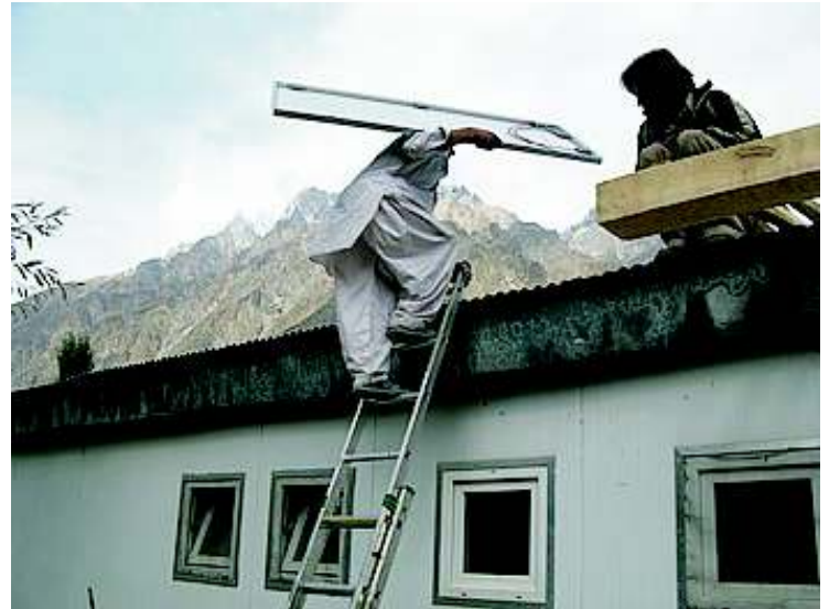
Montáž na střeše nemocnice
