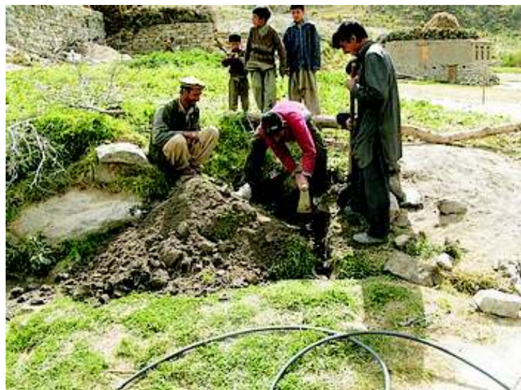
Kopání vodovodní rýhy pro potrubí
