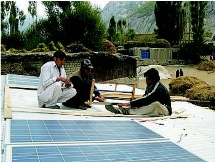
Montáž panelů na střeše nemocnice
