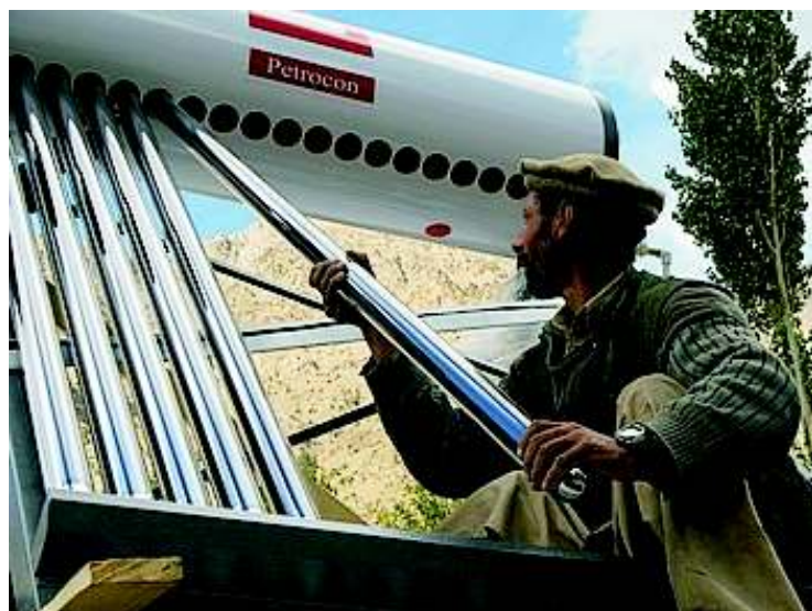
Montáž vakuovaných tubusů
