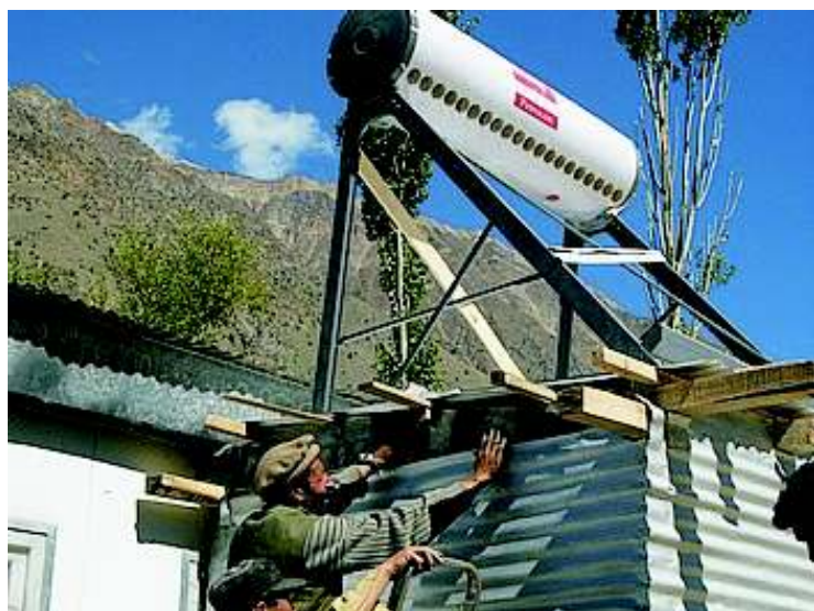
Dokončování opláštění přístřešku
