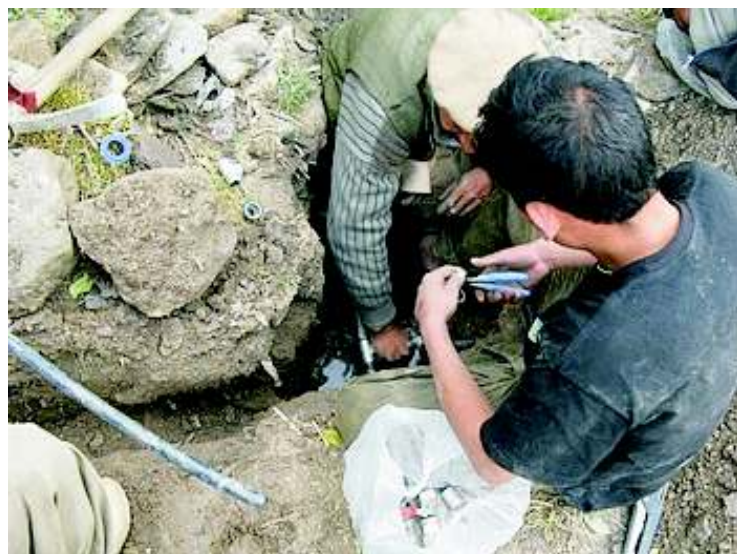
Spojování potrubí
