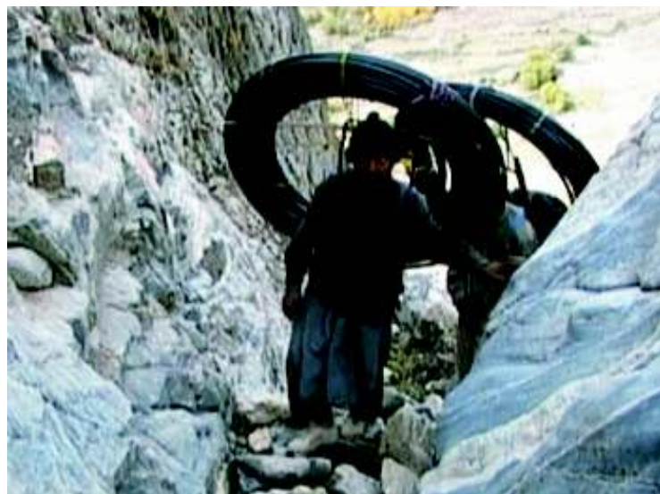
Doprava materiálu ke zdroji pitné vody
