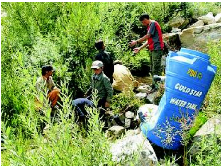
Stavba jímacího jezírka
