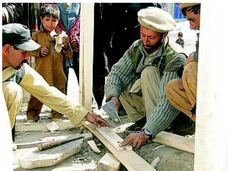
Budování přístřešku pro ohřev vody v nemocnici
